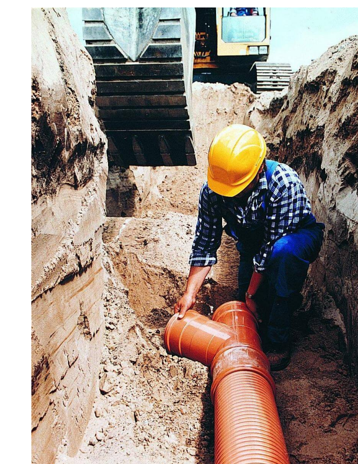
El PVC s'utilitza molt en les canonades del clavegueram pel seu baix cost, la seva resistència química i la seva facilitat d'unió. Font: https://commons.wikimedia.org/wiki/File:Laying_sewer_hi_res_(2).jpg
